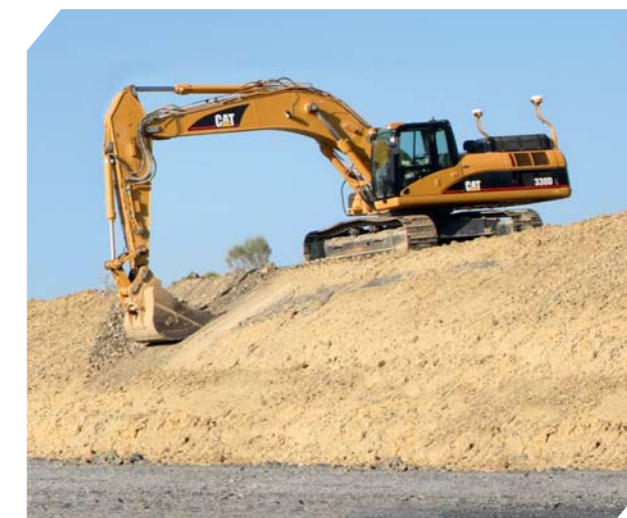
Budování násypů a protihlukových stěn
